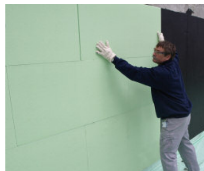
Insérez les plaques isolantes périmétriques Styrodur ® dans le lit de collage PCI Pecimor DK.
